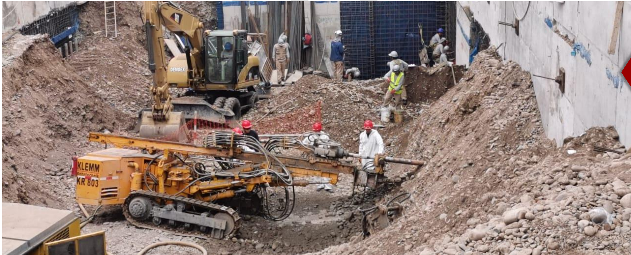
PERFORACIÓN TERCER ANILLO
