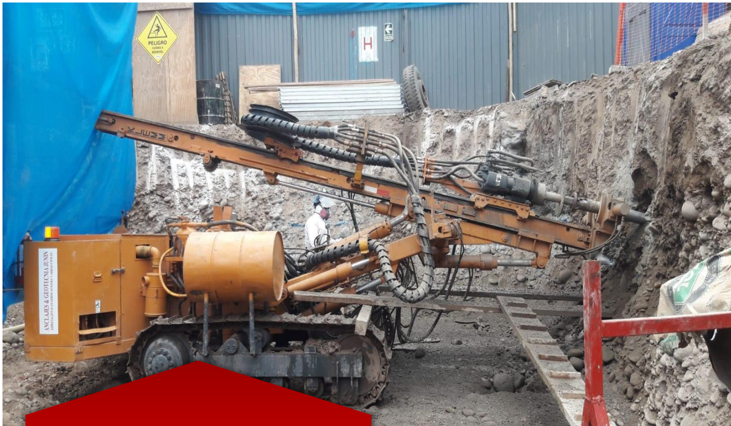
PERFORACIÓN DEL PRIMER ANILLO
