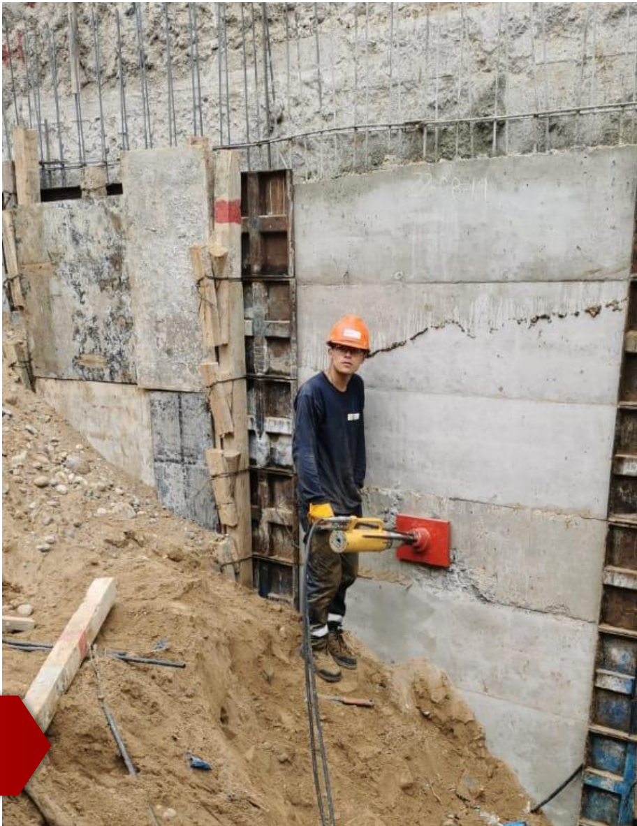
CORTE DE CABLES
