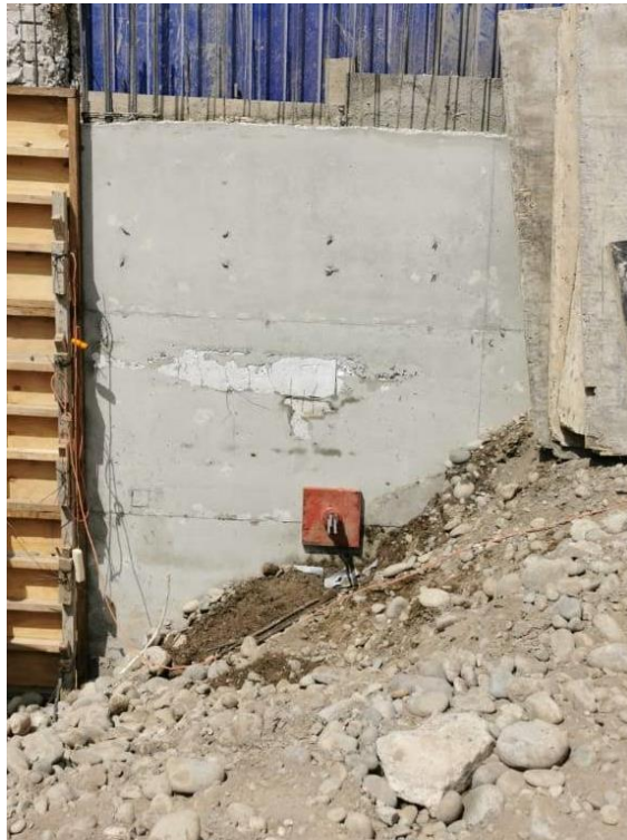
Muro Anclado
