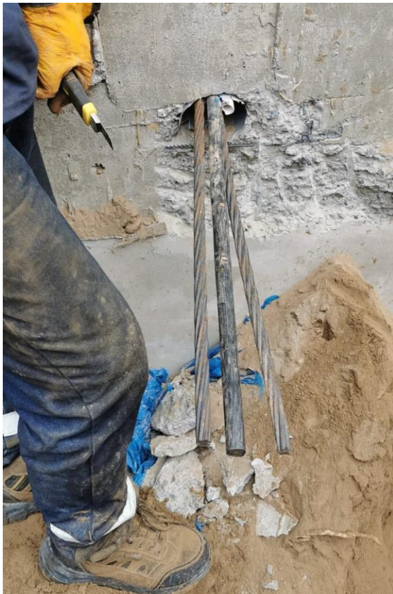
Corte de sobrante de mecha de cables
