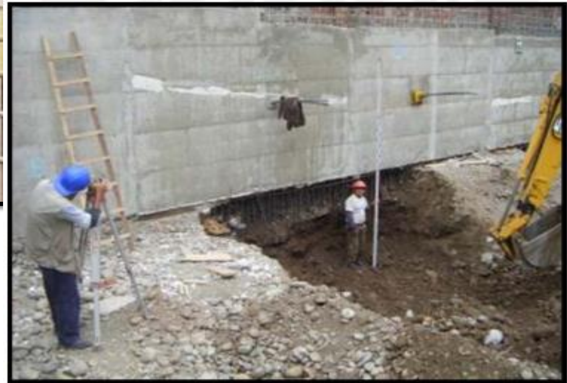
Imagen 24. Excavación de banqueta y perfilado
