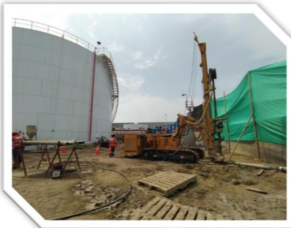
Micropilotes para cimentación de tanque
