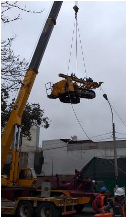
Extracción de la perforadora
