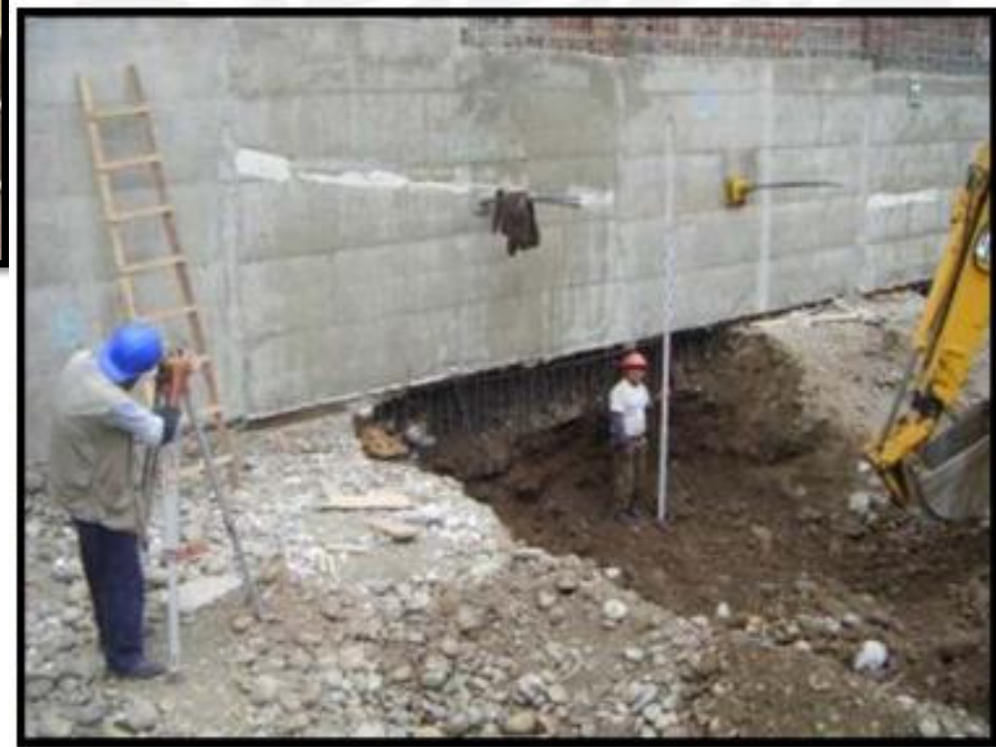
Imagen 24. Excavación de banqueta y perfilado
