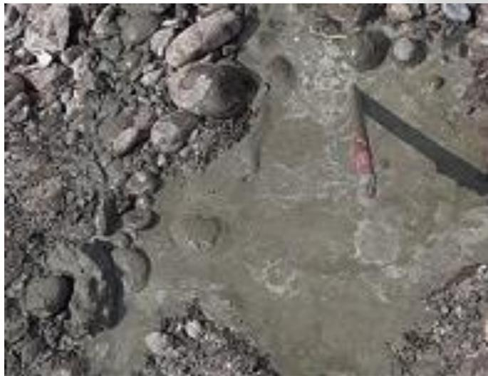
Anclaje inyectado a gravedad
